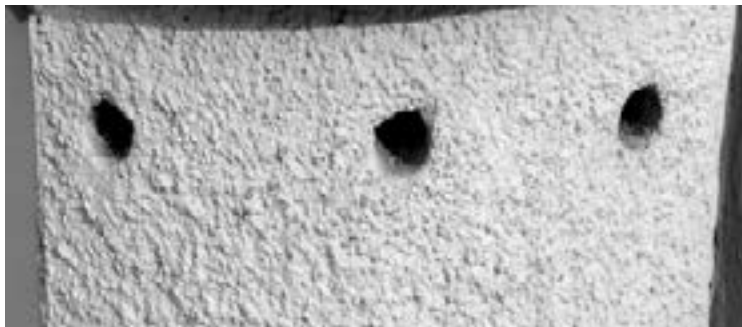
Perforaciones en las paredes de adobe, hechos por Armando Benard N. para evitar la humedad.
