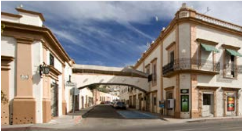
Puente que enlaza los dos edificios
