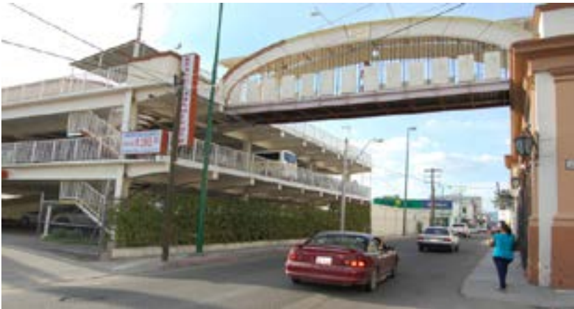
Puente del hotel hacia el estacionamiento
